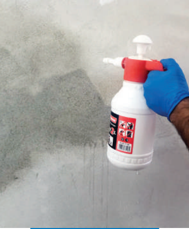
Διαβροχή του υποστρώματος
