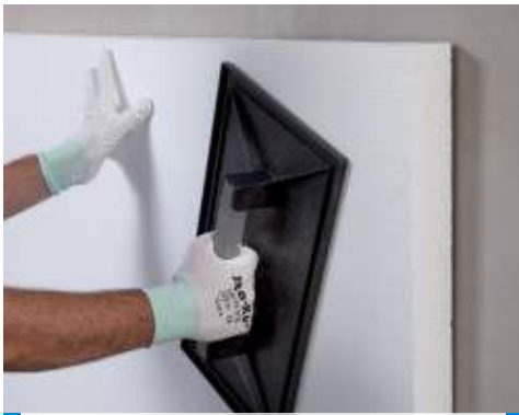
Εφαρμογή πίεσης στη θερμομονωτική πλάκα, ώστε να εξασφαλιστεί η καλή συγκόλλησή της με το υπόστρωμα
