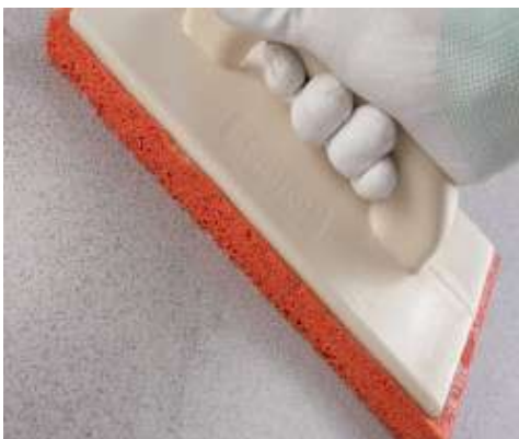
Φινίρισμα της εξομαλυντικής στρώσης με σπογγώδες τριβίδι
