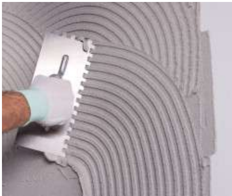
Εφαρμογή της πρώτης εξομαλυντικής στρώσης του Mapetherm AR1 GG
