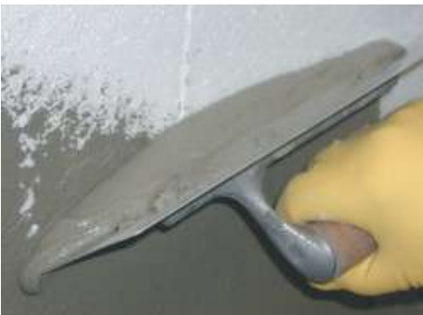
Εφαρμογή του Mapetherm AR1 στην πλάτη της μονωτικής πλάκας με οδοντωτή σπάτουλα
