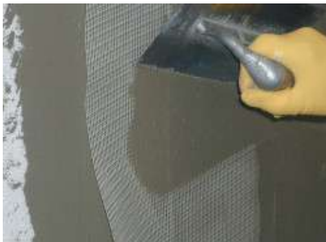
Εξομάλυνση θερμομονωτικών πλακών ενισχυμένων με υαλόπλεγμα που έχει ενσωματωθεί στη στρώση του Mapetherm AR1
