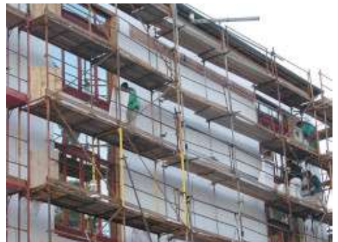
Εφαρμόστε πίεση στις μονωτικές πλάκες μόλις τοποθετηθούν. Έτσι εξασφαλίζεται η καλύτερη συγκόλληση στο υπόστρωμα
