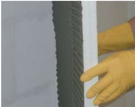
Τοποθέτηση της θερμομονωτικής πλάκας
