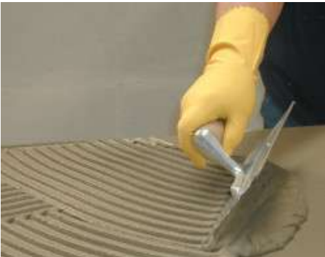
Εφαρμογή του Mapetherm AR1 στην πλάτη της μονωτικής πλάκας με οδοντωτή σπάτουλα
