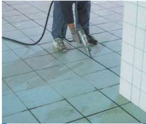
Σφράγιση αρμού διαστολής κεραμικών με Mapesil AC
