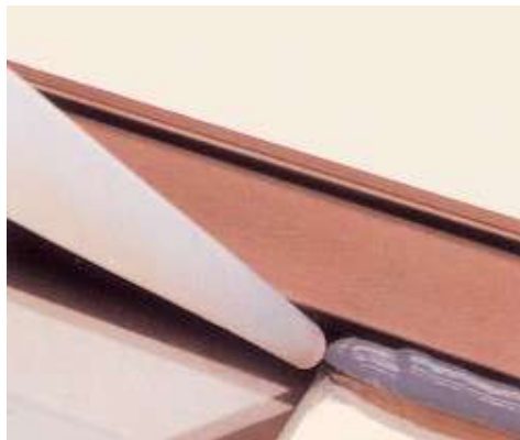
Σφράγιση με Mapesil AC ενός κουφώματος αλουμινίου
