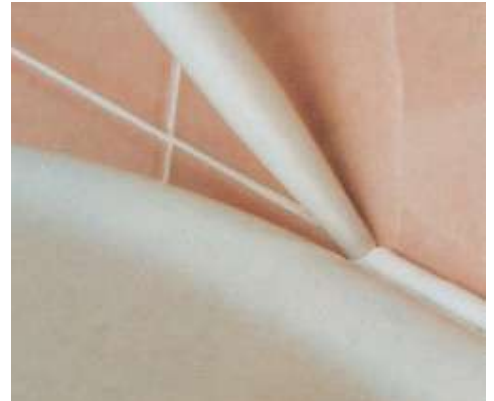
Σφράγιση ειδών υγιεινής
