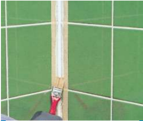
Εξομάλυνση του αρμού με σαπουνόνερο και ένα μικρό πινέλο
