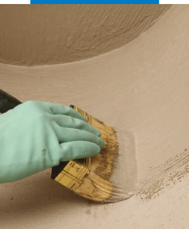
Στεγάνωση λεπτομερειών με πινέλο
