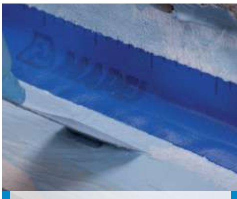
Τοποθέτηση Mapeband σε αρμό μεταξύ δαπέδου-τοιχού με Mapelastic® AquaDefense
