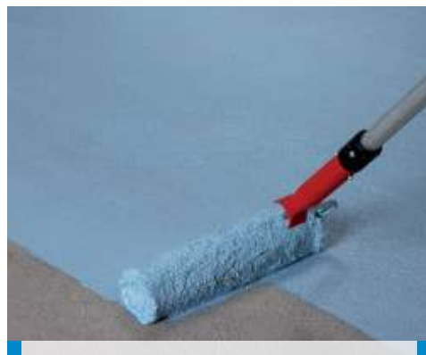
Εφαρμογή της πρώτης στρώσης του Mapelastic® AquaDefense σε τσιμεντοκονία δαπέδου
