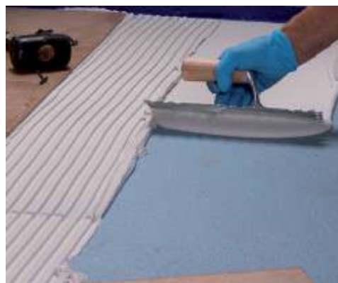
Τοποθέτηση πλακιδίων στην επιφάνεια του Mapelastic AquaDefense
