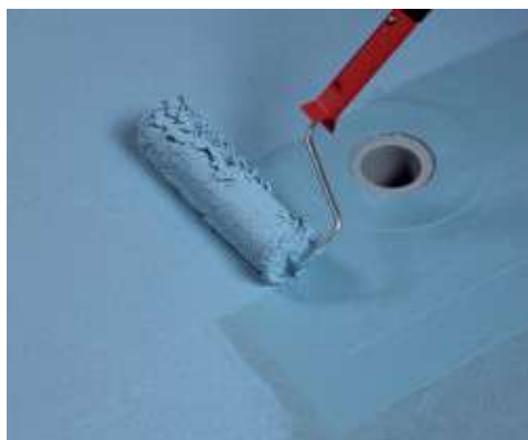
Εφαρμογή της δεύτερης στρώσης του Mapelastic® AquaDefense με ρολό
