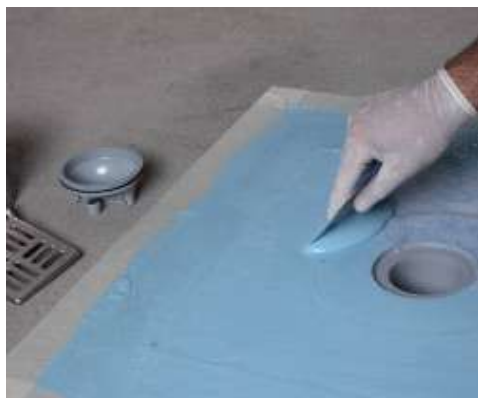
Εμποτισμός υφάσματος της σειράς Drain Vertical με Mapelastic® AquaDefense
