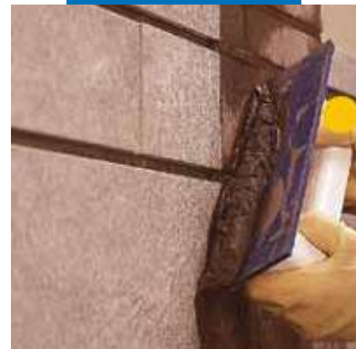
Αρμολόγηση με Ultracolor Plus σε τοίχο με λαστιχένια σπάτουλα
