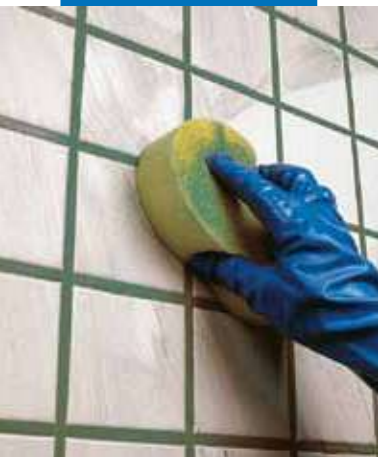
Τελείωμα και καθαρισμός αρμών πλακιδίων τοίχου με σφουγγάρι
