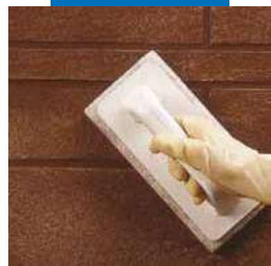
Καθαρισμός αρμών με Scotch-Brite® (όταν το προϊόν είναι μερικώς ωριμασμένο)
