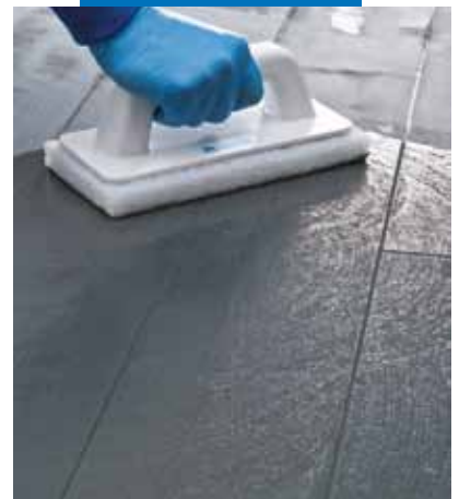
Καθαρισμός αρμών με Scotch-Brite® (όταν το προϊόν είναι μερικώς ωριμασμένο)
