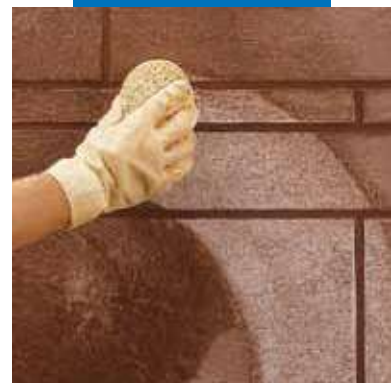
Τελείωμα και καθαρισμός αρμών πλακιδίων με σφουγγάρι
