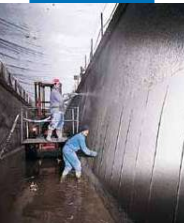
Υδροηλεκτρικό κανάλι Bertini - Robbiate (Como) - Ιταλία: τελείωμα με σπάτουλα
