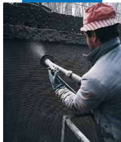
Υδροηλεκτρικό κανάλι Bertini - Robbiate (Como) - Ιταλία: εφαρμογή με ψεκασμό
