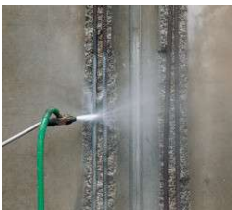
Καθαρισμός ράβδων οπλισμού
