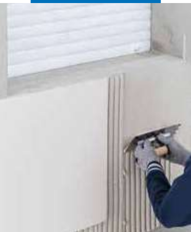
Εφαρμογή κεραμικών πλακιδίων μεγάλων διαστάσεων
