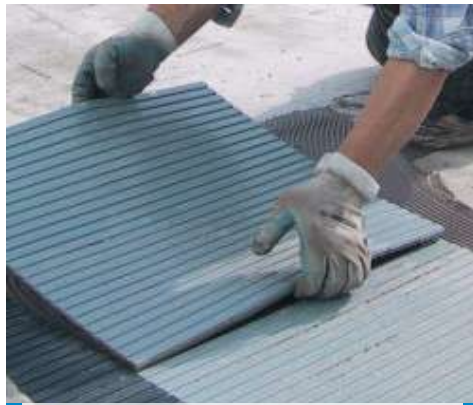
Τοποθέτηση πλακιδίων καουτσούκ με Granirapid
