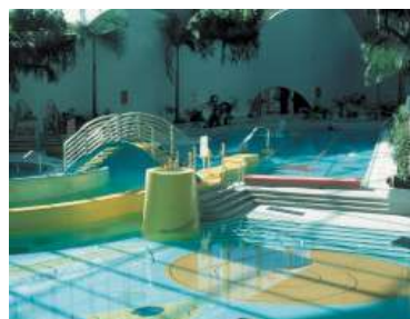
Τοποθέτηση ψηφίδων και klinker σε πισίνα
