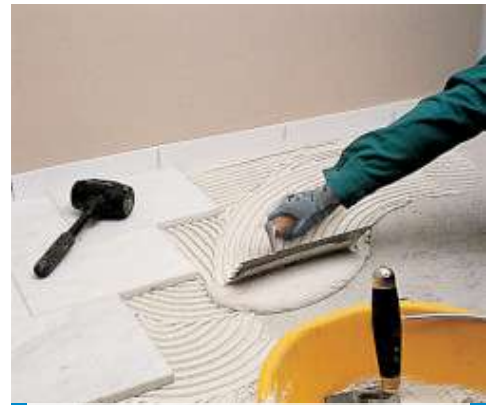
Τοποθέτηση λευκού μαρμάρου Carrara με λευκό Granirapid
