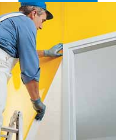
Τοποθέτηση ταπετσαρίας σε ρολά με την Adesilex MT32
